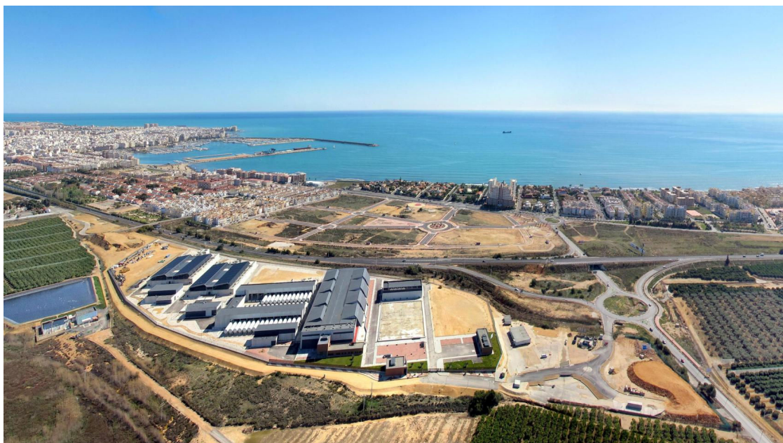
Desaladora de Torrevieja.
