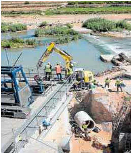
Obras en La Presa. AYTO. VALENCIA
