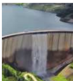
La presa de El Atazar desagua por el aliviadero superior. CYR
